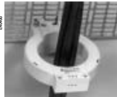
Монтаж на пластине
